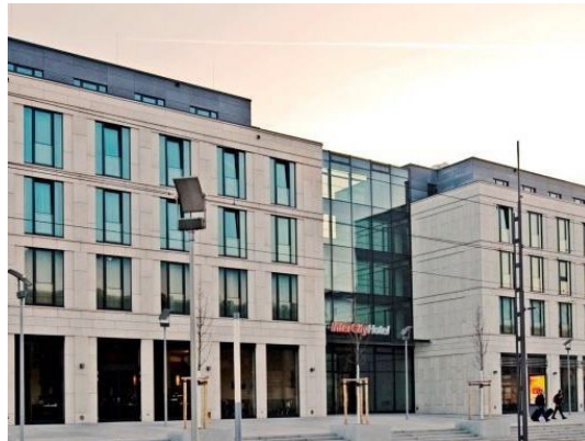
Hotel- Bürokomplex Wiener Platz, Dresden
