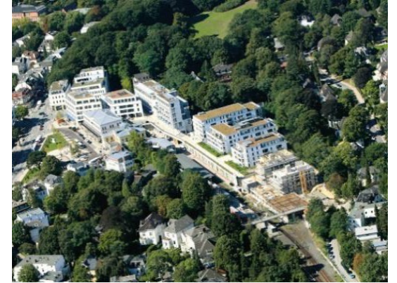
Quartier Blankenese Bahnhofplatz, Hamburg
